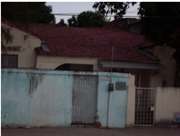
REU Dom Hélder Câmara, Av. Carapinima, 1655.
